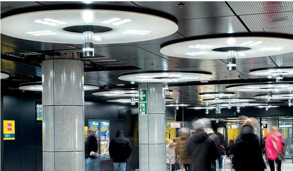
Schwarze Deckenelemente bilden einen deutlichen Kontrast zu den anderen Bereichen des Bahnhofs. Im Foyer schweben über den Besuchern matt weiß lackierte Reflektorringe mit bündig eingelassenen, axial angeordneten LEDs. In Kombination mit zylindrischen Leuchten, die das Licht über eine ausgeklügelte Spiegeltechnik auf die weißen Scheiben lenken, entsteht eine sicherheitsgerechte und zugleich ansprechende Beleuchtung.
